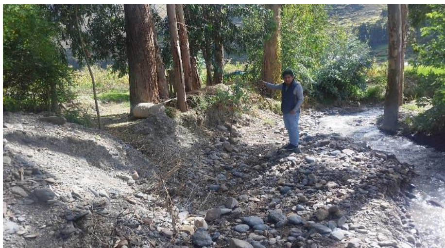
FIGURA N° 02: SE APRECIA EL CAUCE COLMATADO, EL CUAL INTERRUMPE EL NORMAL FLUJO DEL AGUA, REQUERIENDO LA LIMPIEZA Y DESCOLMATACIÓN DEL CAUCE DE LA QUEBRADA UCHULLUCYO.
